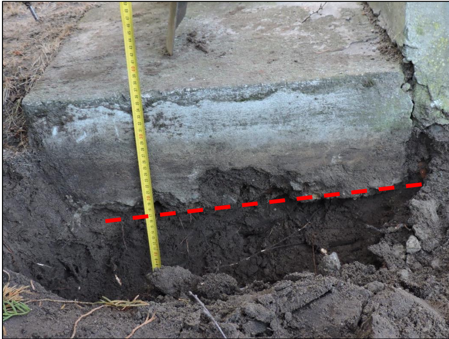
Fot. 11 Miejsce założenia izolacji poziomej (pomiędzy częścią pomnika a warstwą gruzu)
