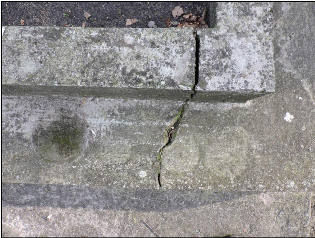
Fot. 8 Rama nagrobka, fragment, pokrycie wtórną szlichtą, w polu widzenia głębokie spękanie.
