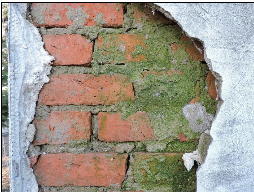
Fot. 7 Tylna strona pomnika, fragment, w polu widzenia wtórne uzupełnienie wyprawy tynkarskiej z zatopioną siatką podtynkową.
