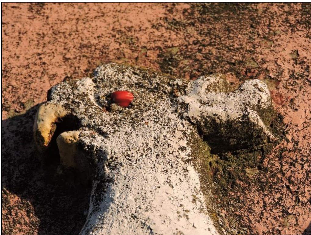
Fot. 3 Element dekoracyjny, fragment, w polu widzenia wtórna polichromia, nałożona nierównomiernie (brak warstwy malarskiej w zagłębieniach).
